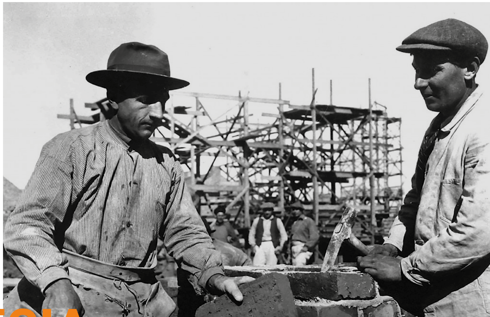
HSB Hyresgästernas sparkasse - och byggnadsförening, una asociación de construcción y ahorro de los arrendatarios. Desde el lugar de trabajo, en kv fatet.
